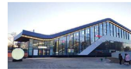
СТАНЦИЯ МЦД ОПАЛИХА Московская область
