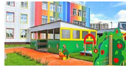
ДЕТСКИЙ САД НА МОСКОВСКОМ Ш. г. Санкт-Петербург
