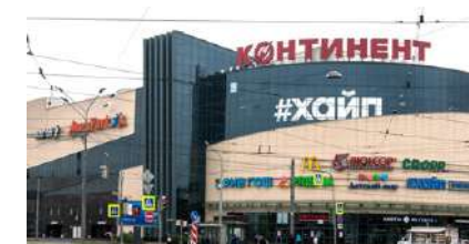
ТЦ КОНТИНЕНТ г. Санкт-Петербург
